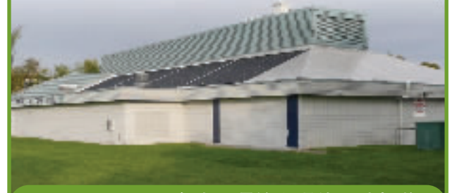
Templeton Park 泳池屋頂的太陽能電池板將減少溫室氣體排放 – 相等於在油站入滿 882 輛，每缸 40 公升汽油容量的車輛。
