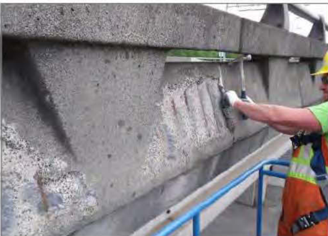
D17. Loose concrete at existing parapet spalls D14-D15.
