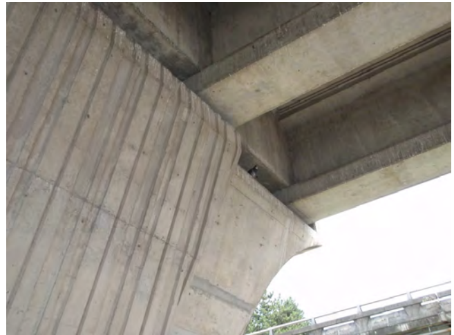
D-8 I-28.jpg D2, east abutment.
