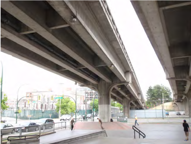
D-8 I-19.jpg Main Street ramp.
