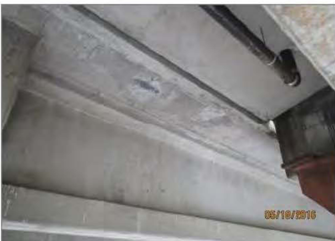
D11. Deck soffit spall at south overhang in span D19-D20.
