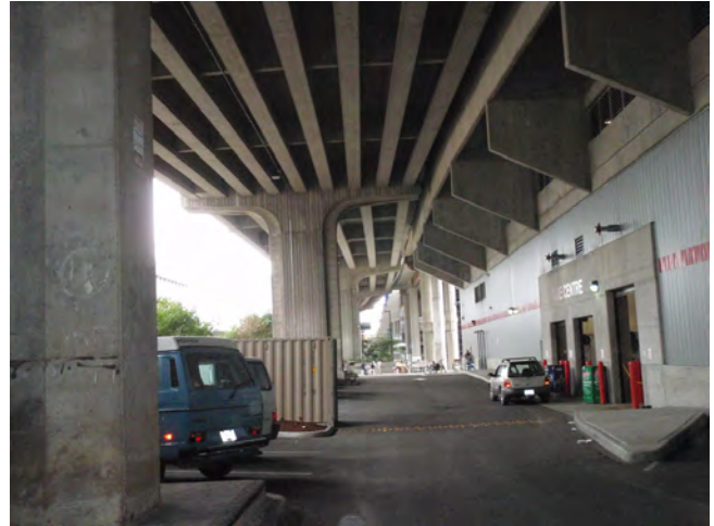
D-8 I-20.jpg Typical soffit.
